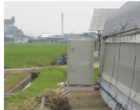
【開花棟の室外機設置状況】
