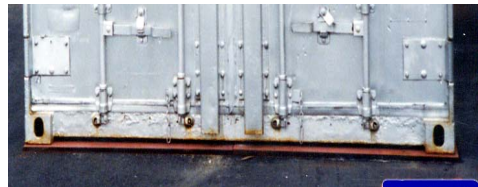
コンクリート整地直設置方法
