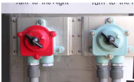
庫内灯、非常ベル用スイッチ類
